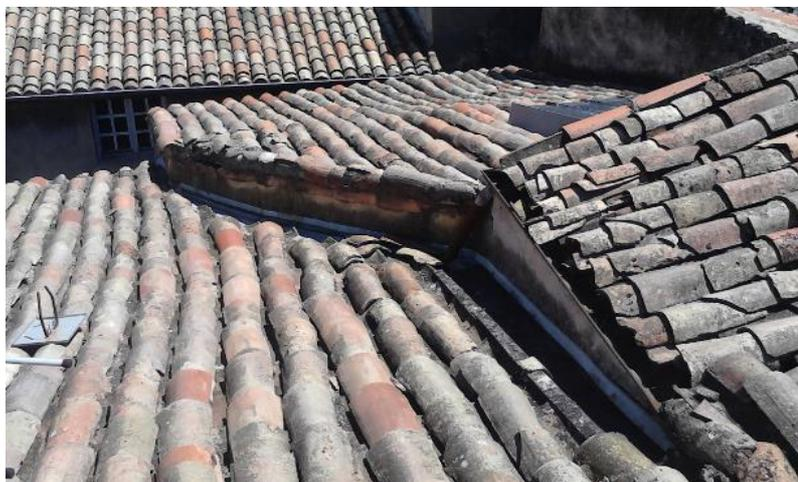
Donc le muret actuellement en brique sera détruit et remplacé par une armature bois recouverte de feuilles d’étanchéité en zinc, cela pour ne pas alourdir inutilement cette zone de toiture.
