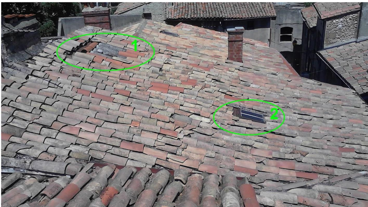
À noter : Une des fenêtres de toit est obturée par une tôle ondulée (numérotée en "1" sur la photo ci-dessus).
