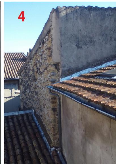
– Les façades devront être décrépites totalement, seuls les joints les plus endommagés seront grattés et les pierres de maçonnerie simplement nettoyées à l'eau. En effet, leur état ne nécessite pas d'hydrofugation.
