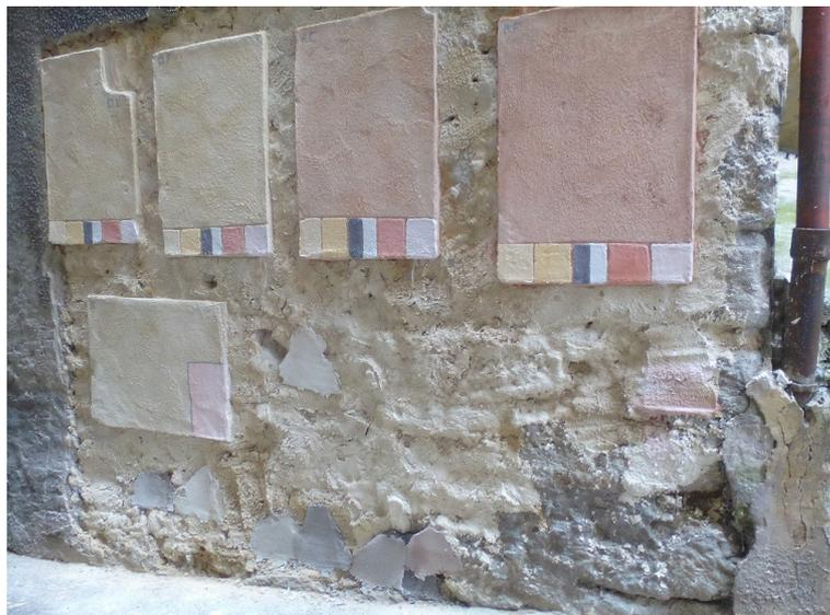
L'enduit de façade sera fait en chaux teintée dans la masse à l'ocre naturelle ; l'intensité des couleurs devra être décidée avec l'architecte coloriste DPLG d'urbanisme. Des échantillonnages ont donc dû être réalisés, sur un mur de test.
