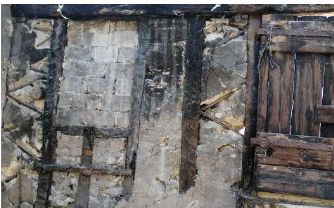
La réhabilitation des ouvertures de l'élévation fera l'objet d'une future déclaration, puisqu'elle dépend de potentiels travaux de climatisations dont les fonds ne sont pas encore à notre disposition. Toutefois, ce pan de façade bien trop dégradé devra être détruit, une structure et couverture bois viendra alors en remplacement provisoire.
