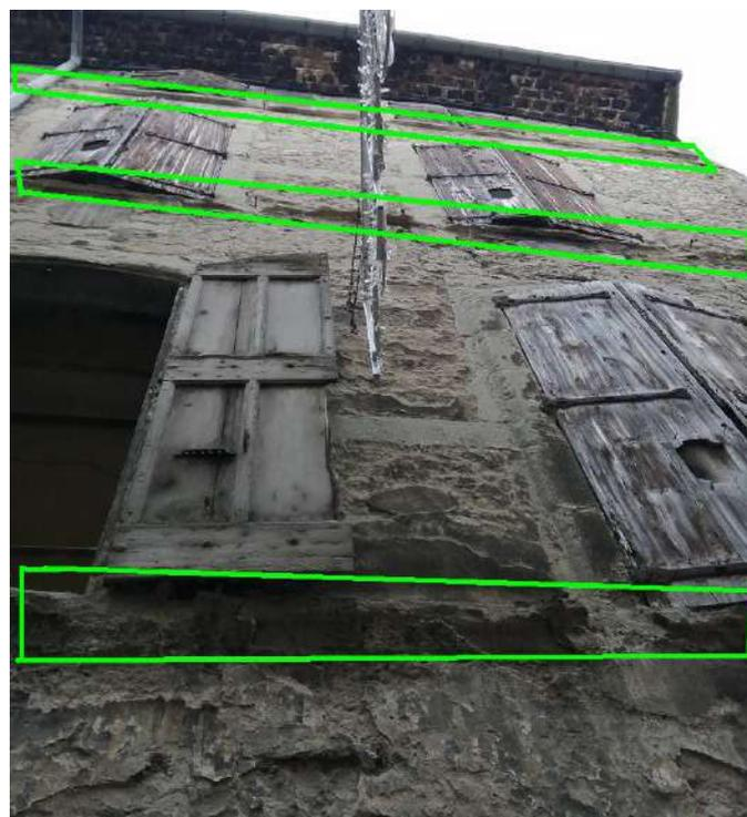
Les corniches sont actuellement dans un état de dégradation avancée et plusieurs devis pour les remplacer intégralement par de la pierre de taille ont été réalisés, malheureusement la quantité nécessaire (40 m<sup>3</sup>), fait exploser notre budget ; l'utiliserons de moules garnis d'enduit et renforcées d'inox, est pour le moment la seule hypothèse valable...
