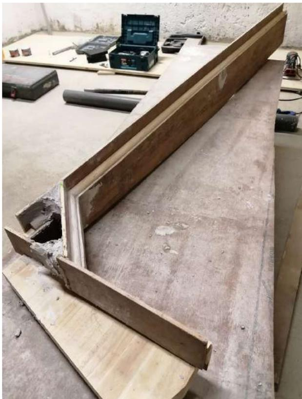
Ou en coffrage de mortier à la chaux directement sur la façade. (goujonnage inox nécessaire)
