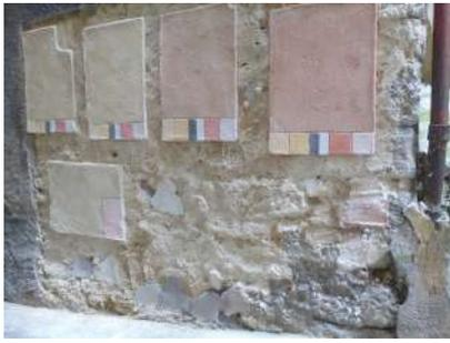
Les façades devront être décrépitées totalement, les joints grattés et les pierres de maçonnerie nettoyées à l'eau.
